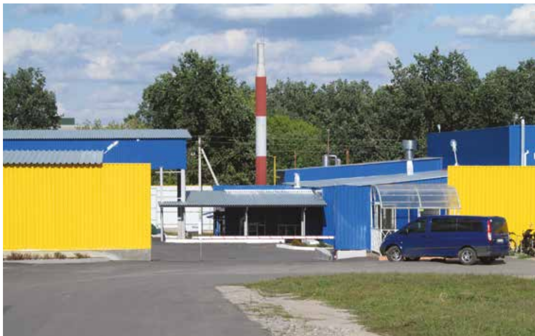
До начала работ
