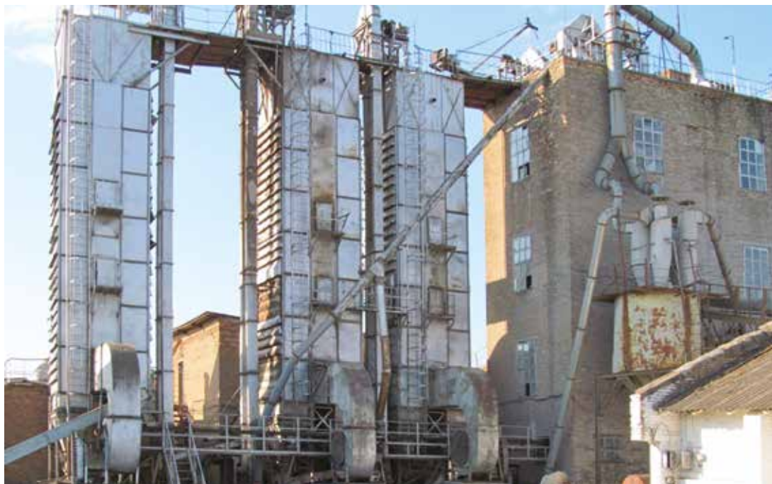
До начала работ
